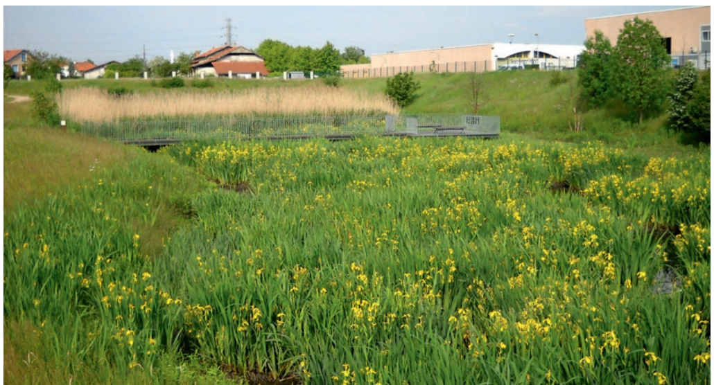
Figure 4 Intégration paysagère d'un bassin d'infiltration. Bassin Minerve, Saint-Priest, Rhône ; crédit photo OTHU.
