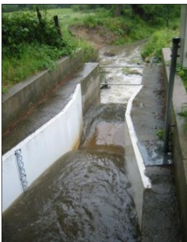
Le canal Parshall de la station de la Léchère sur la Chaudanne et la station météo de Montromant (Yzeron)
