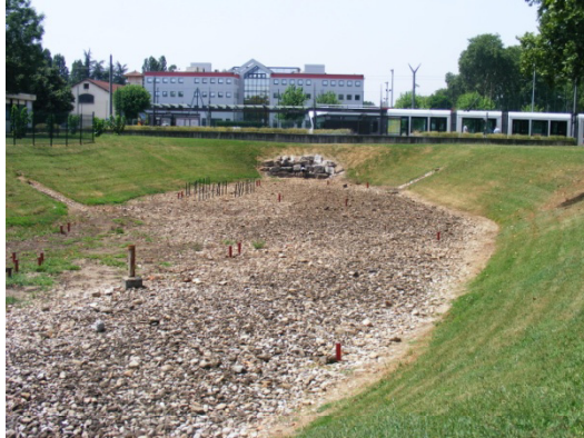
Figure 5 : instrumentation du site de l'IUT.
