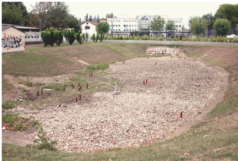
Figure 13: instrumentation du site de l'IUT. En 2008, le bassin d'infiltration comprend un total de 61 piézomètres, tubes en plexiglas ou tubes métalliques permettant d'échantillonner et d'inspecter par vidéo-caméra le lit d'infiltration et la nappe phréatique.
