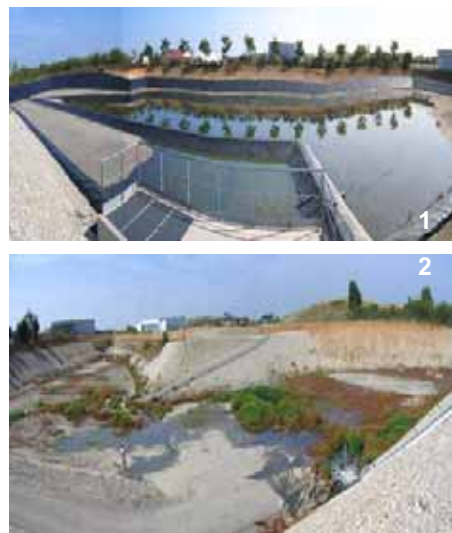
Figure 5 : Bassin de rétention (1) et Bassin d'infiltration (2) du site Django Reinhardt
