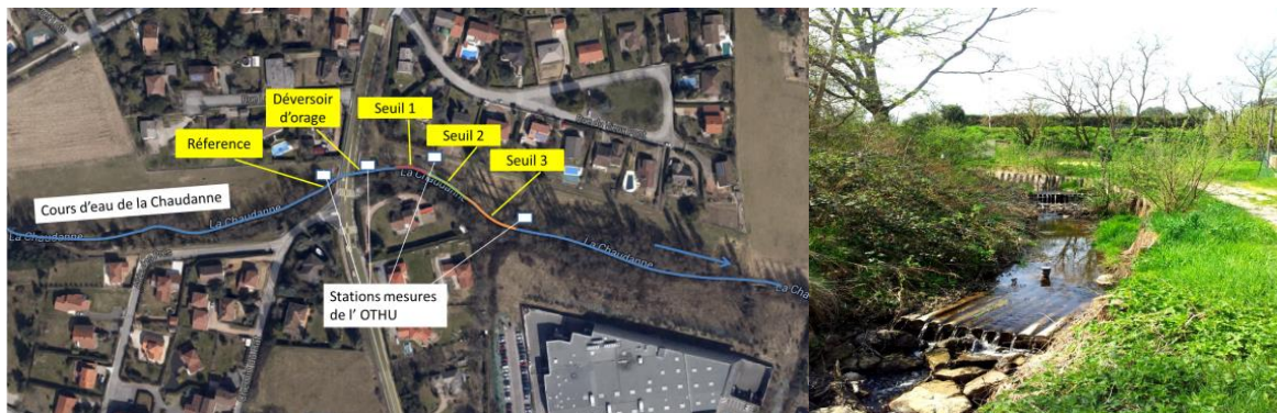
Figure 37 : vue d'ensemble du dispositif et vue d'un seuil poreux.
