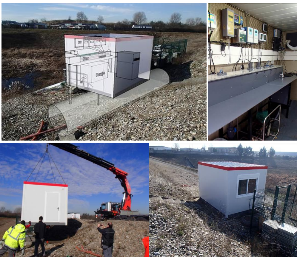
Figure 2 : Mise en place du nouveau bungalow à l'entrée du bassin d'infiltration de Chassieu
