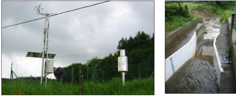
Figure 15. La station météo de Montromant (Yzeron) et le canal Parshall de la station de la Léchère et sur la Chaudanne
