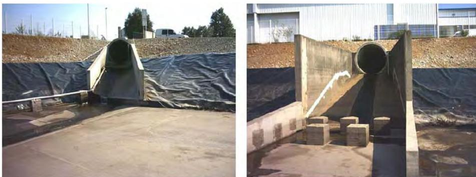
**Figure 3-4.** Collecteurs d'entrée du bassin de rétention : entrée 1 (à gauche) et entrée 2 (à droite) (Torres, 2008).
