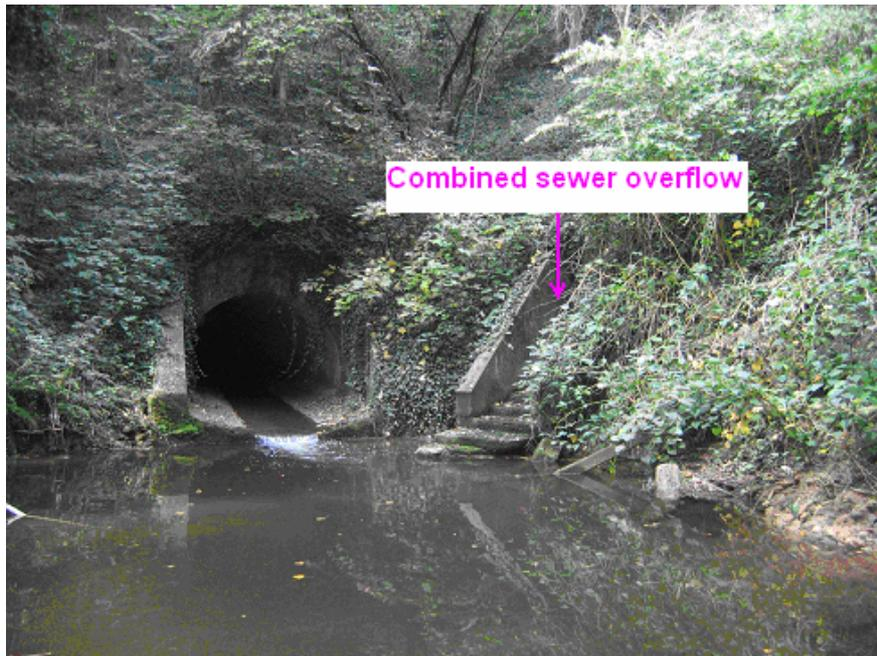
**Figure 3-6.** Photo du déversoir d’orage d’Ecully (photo AD).
