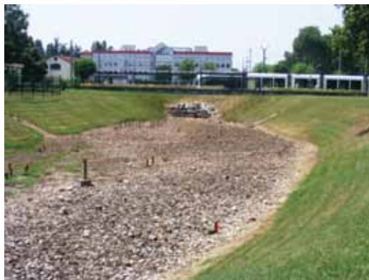
Figure 5 : instrumentation du site de l'IUT.
