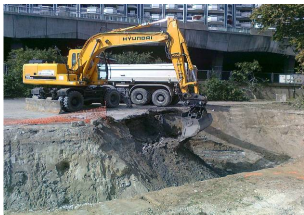
Fouille sur le site de l'ancien port de Courbevoie
