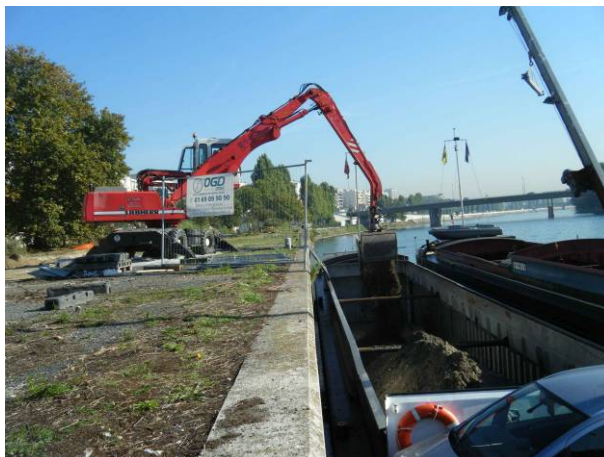
Chargement des barges sur le site de Courbevoie
