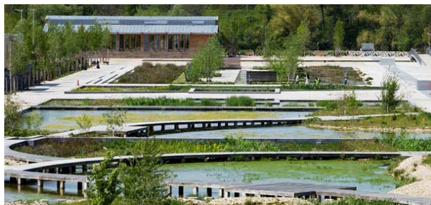
Les bassins filtrants du parc
