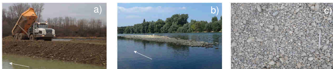
Figure 1. Travaux d'injection des matériaux (a), dépôt résiduel après le premier épisode hydrologique (Q 4 ) (b), photographie d'un dépôt émergé (c).
