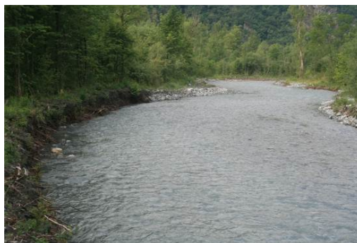
Photo 2. Erosion latérale en rive gauche du bras principal (juin 2014).
