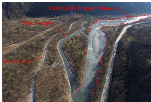
Photo 1. Vue aérienne de l'Île Falcon après travaux (mars 2014, ©Symbhi – Photec).
