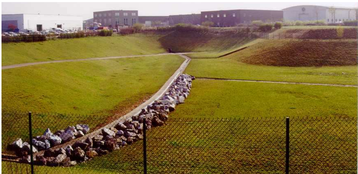
Figure 5 : Vue du bassin de rétention de ZAC du chêne.
