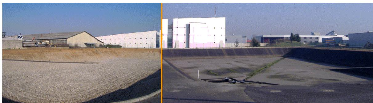
**Figure A. 17 - ZAC de Pivolles – Bassin d'infiltration (gauche) et bassin de rétention(droite)**
