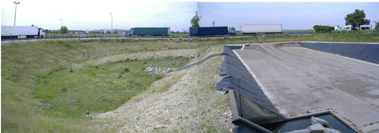
**Figure A. 3 - Centre Routier – Bassin d’infiltration à gauche et bassin de rétention à droite**
