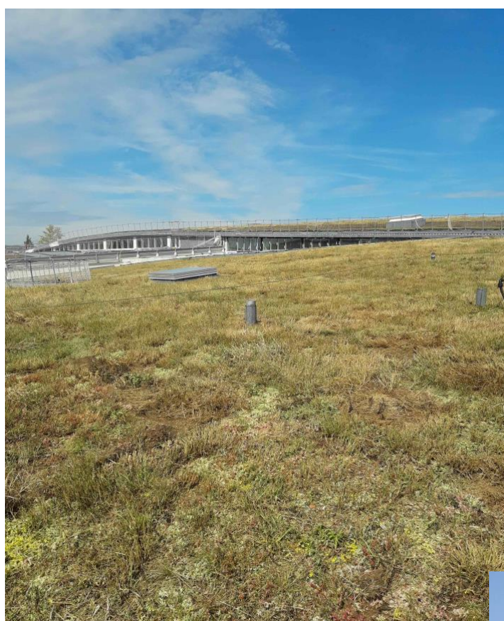
Toiture en faible pente
