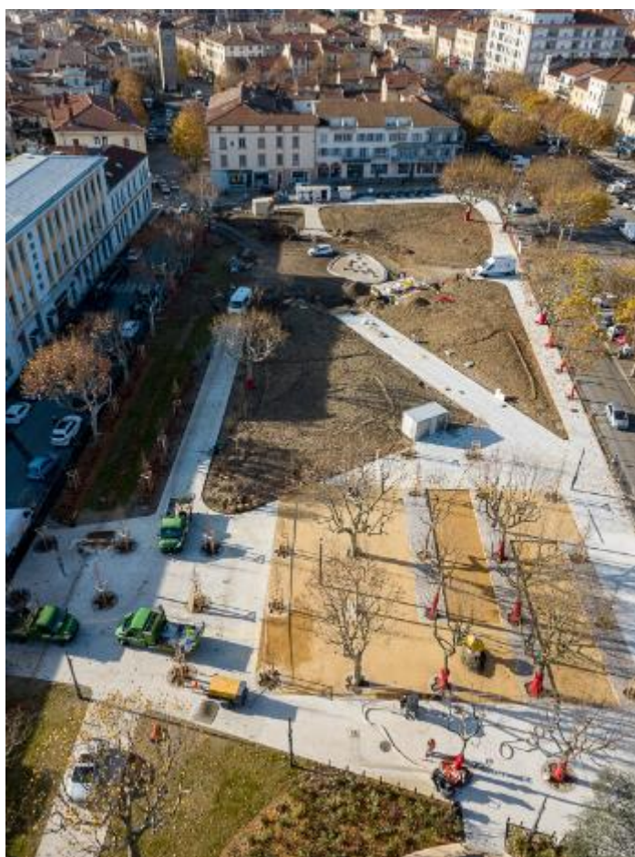
Vue aérienne pendant les travaux d'aménagement
