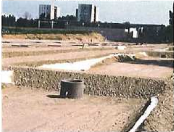
Epandage du ballast avant compactage
