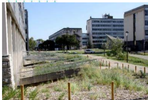
D. Tranchée d'infiltration au pied d'un bâtiment
