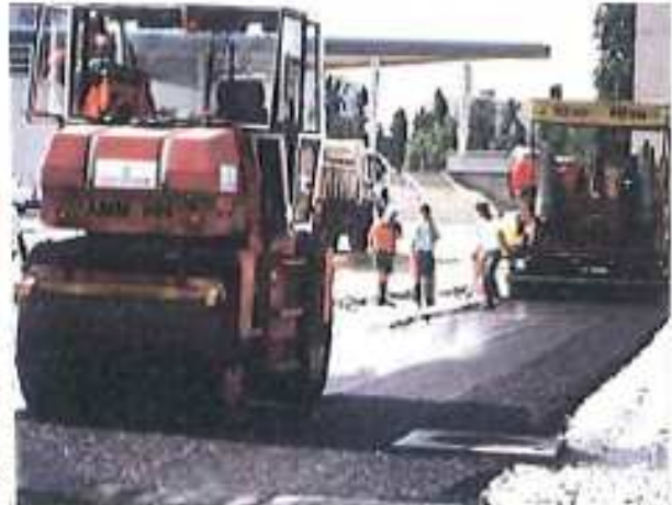
Mise en œuvre du béton bitumineux
