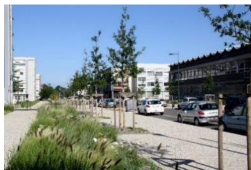
C. Tranchée d'infiltration en bord de voirie
