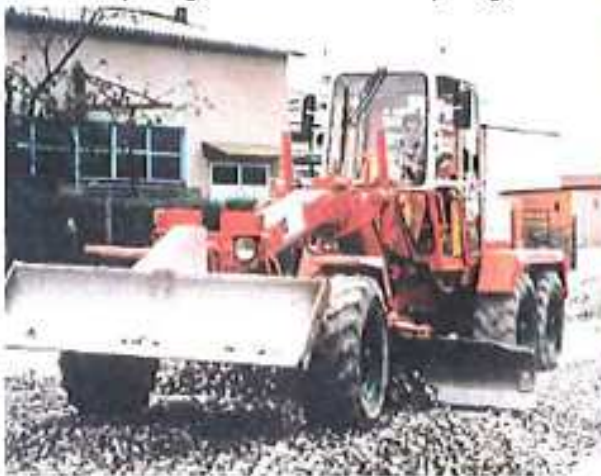
Epandage du ballast avant compactage
