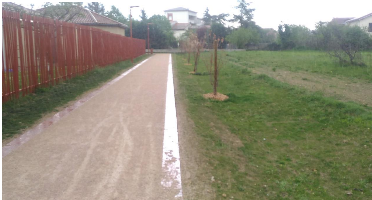
Cheminement piéton longeant une noue paysagère engazonnée et plantée d'arbres
