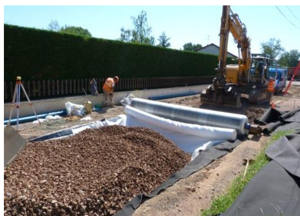
Pose des couches de grave
