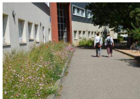
Tranchée d'infiltration plantée au pied d'un bâtiment
