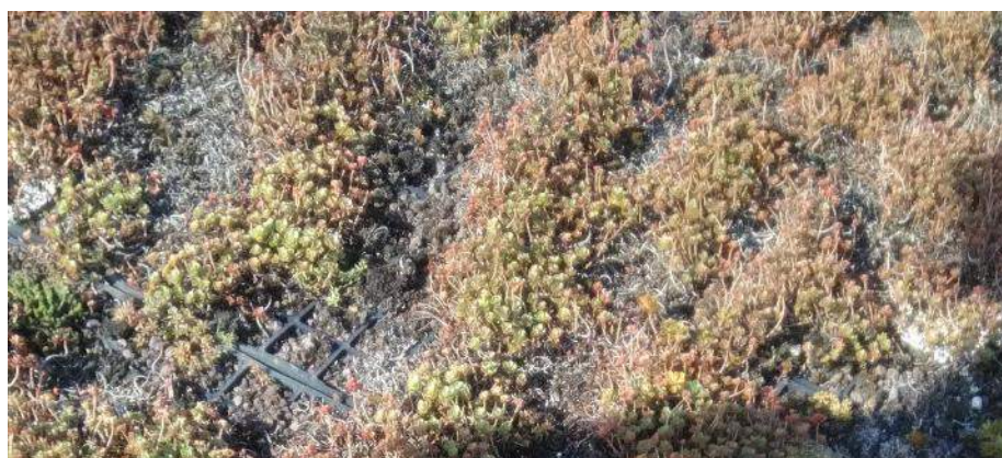
Détail végétation toiture
