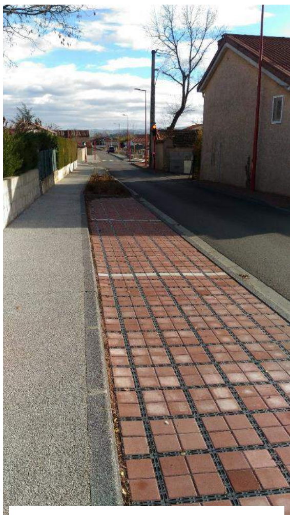
Stationnement en dalles alvéolaires
