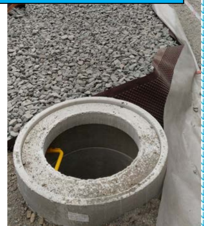
Travaux d'une structure de stockage-infiltration
