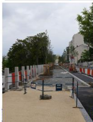
Phase travaux de la promenade
