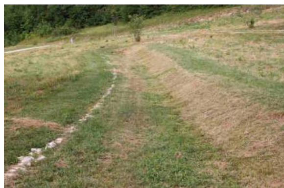
« Gouttière » stockant et ralentissant les eaux de ruissellement et de toitures
