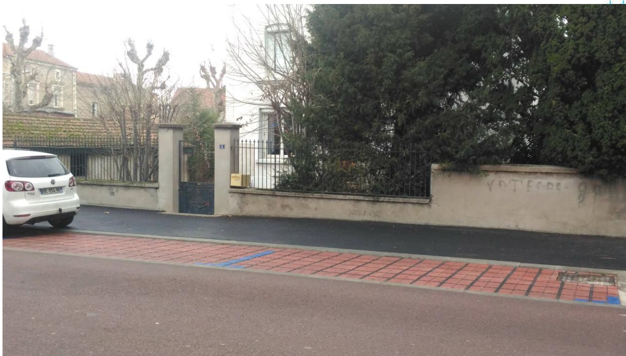
Création de places de stationnement perméables
