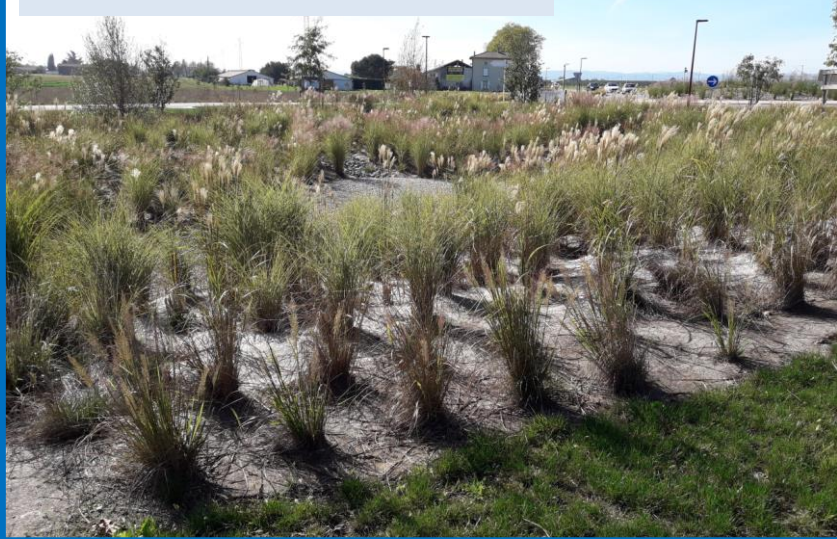
Bassin d'infiltration 1- Giratoire – Graminées
