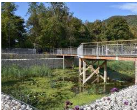
Bassin en eau (pluie annuelle)
