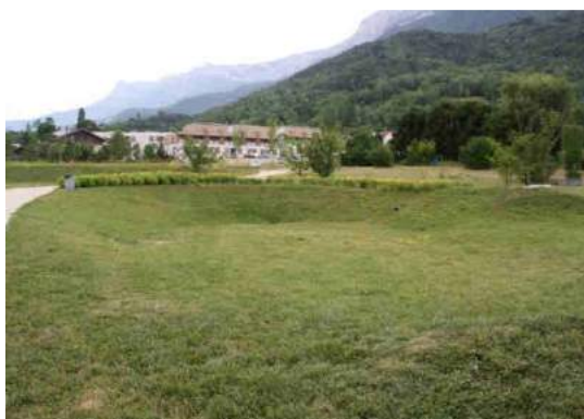
« Lentille » récupérant les eaux de ruissellement et de toitures
