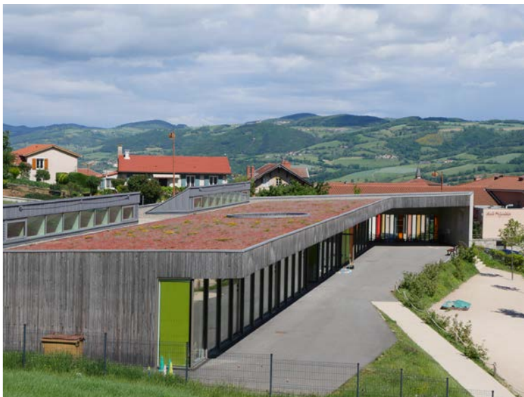
Toiture végétalisée de l'école
