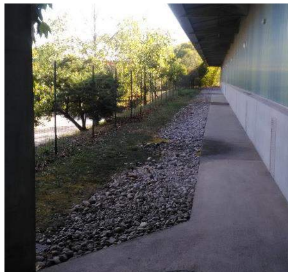
Tranchées d'infiltration sous les toitures
