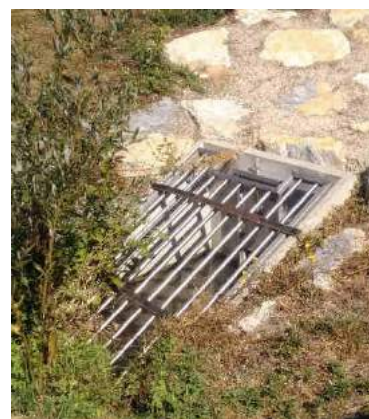
Surverse au pied de l'enrochement
