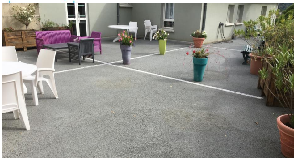
Terrasse revêtue du béton drainant
