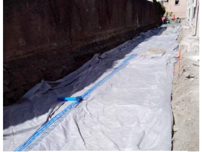
Mise en place de la géomembrane
