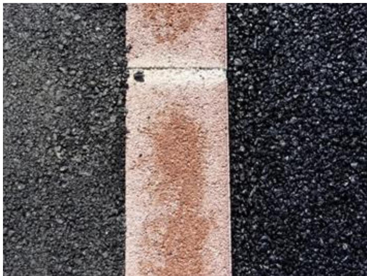
Différence entre l'enrobé drainant (à gauche) et l'enrobé classique (à droite) en cas de pluie
