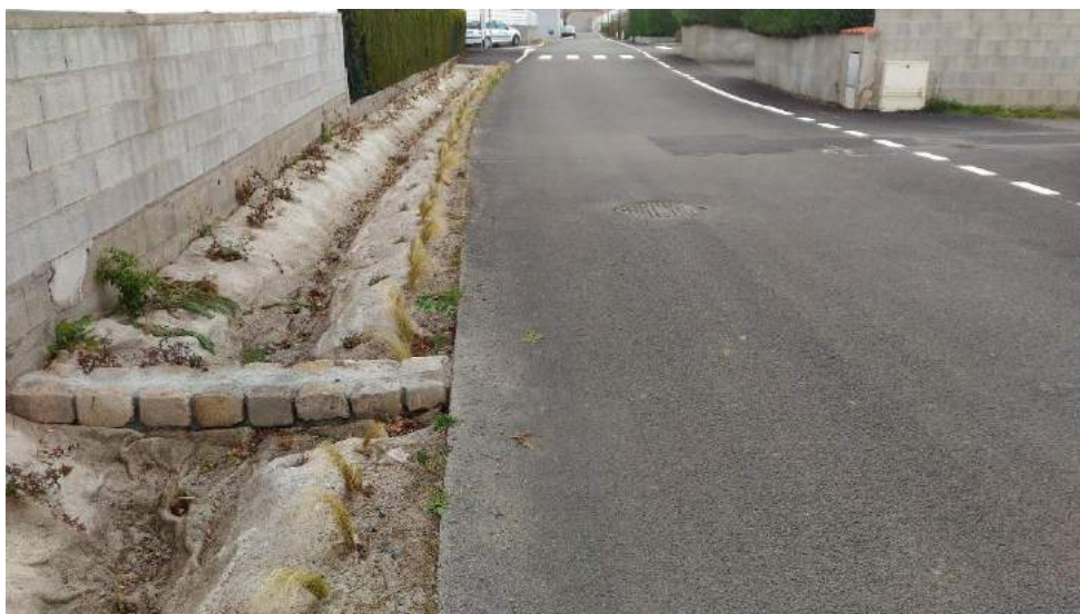
Vue générale de la noue et la voirie. Le massif drainant s'étend sous voirie là où s'arrête la noue.
