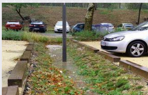
A/ tranchée expérimentale
