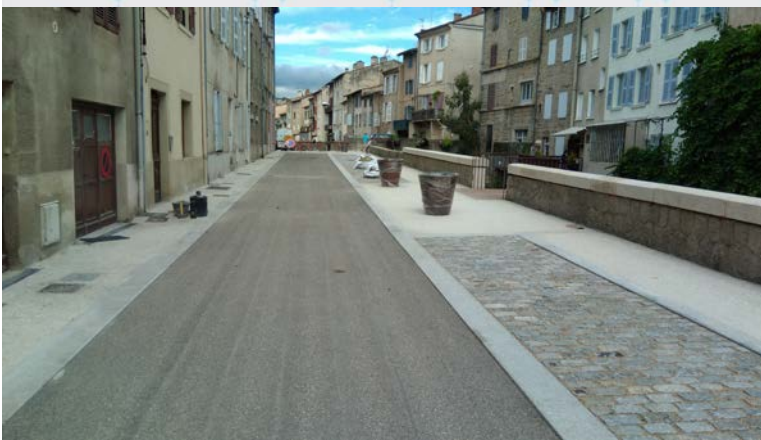
Les quais de l'Astrée après les travaux
