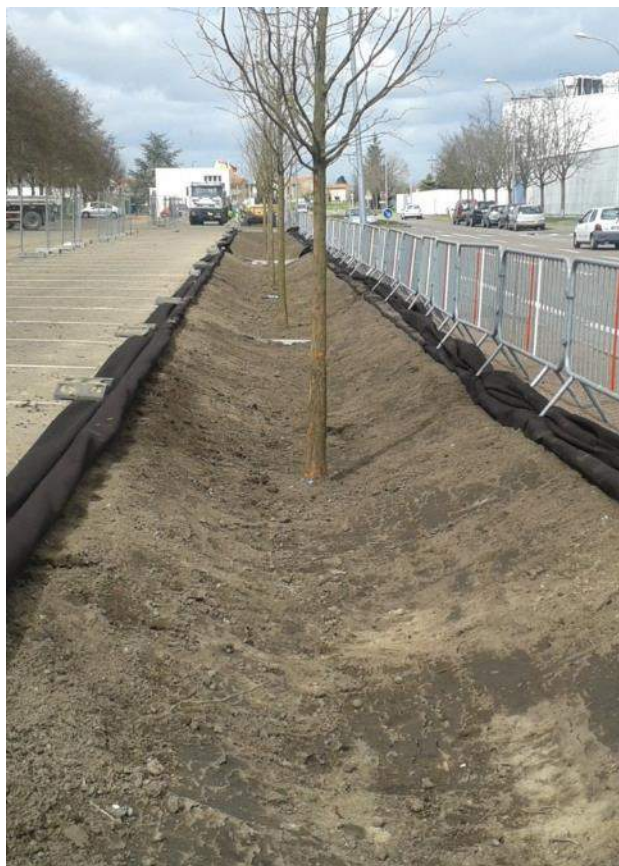
Noue en phase chantier
