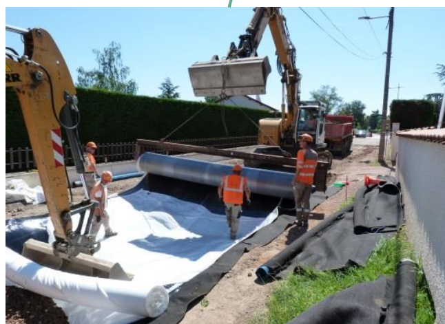
Pose du Géotextile
