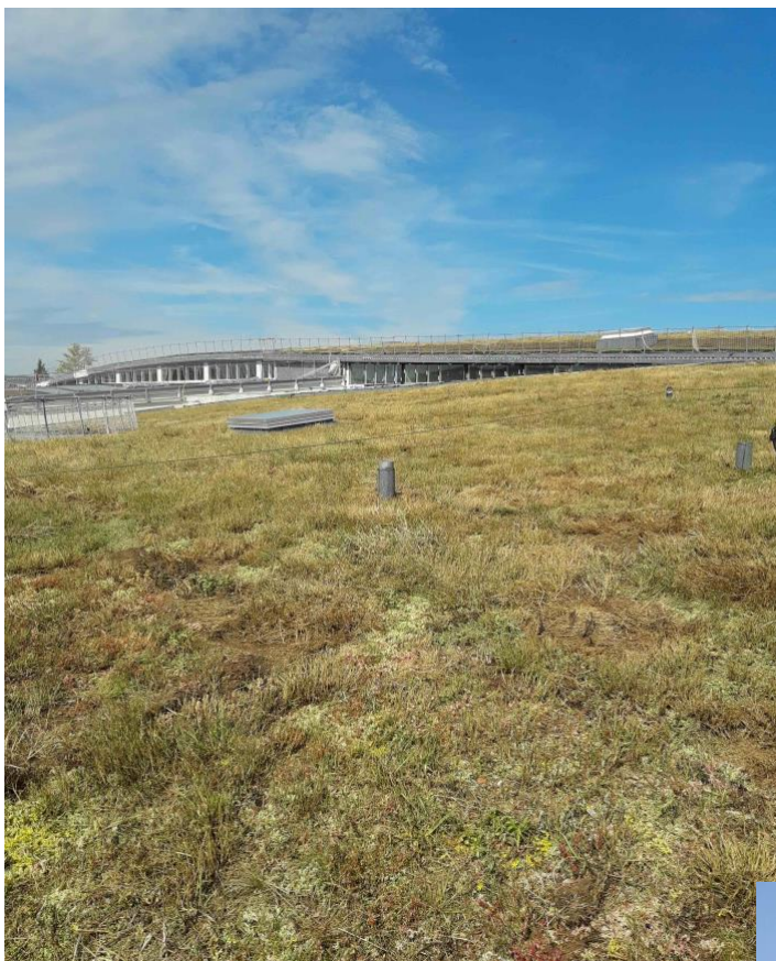
Toiture en faible pente
