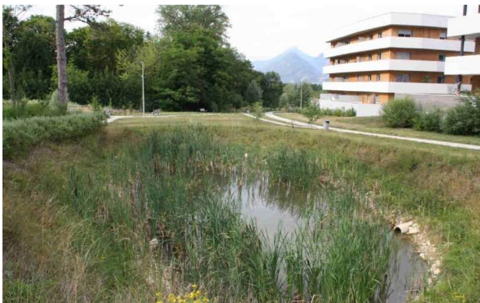
Bassin en eau
