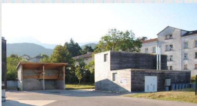
C. La chaufferie bois
