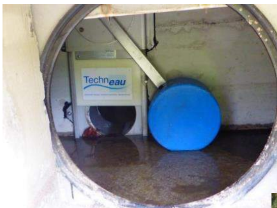
Vue de la vanne sur flotteur
