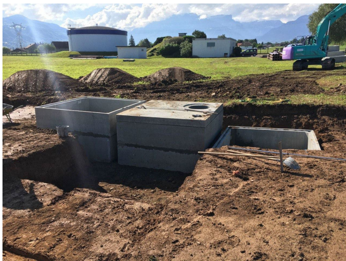
Mise en place des lysimètres (juin 2020)
