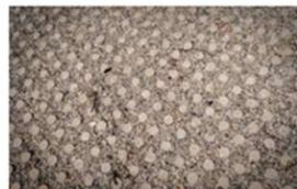
08\_Dalles réticulées rondes -remplissage gravier
