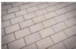
04\_Pavés béton à joints larges en sable
