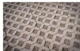
05\_Dalles alvéolées béton -remplissage graviers
