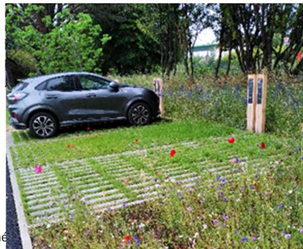
Nécessité de prévoir un substrat stockant (matériaux poreux) sous le revêtement perméable pour assurer la fonction de stockage avant infiltration
