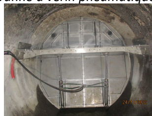
Vanne à vérin pneumatique
