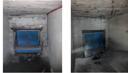
Déversoir équipé d'un Déomatic® (clapet à basculement)
