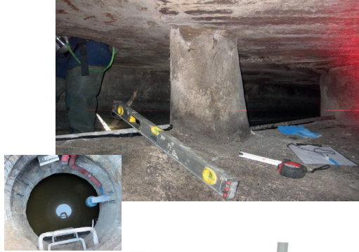
Déversoir latéral en deux parties
