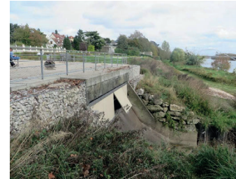
Déversoir frontal de grande largeur (6,60m)
