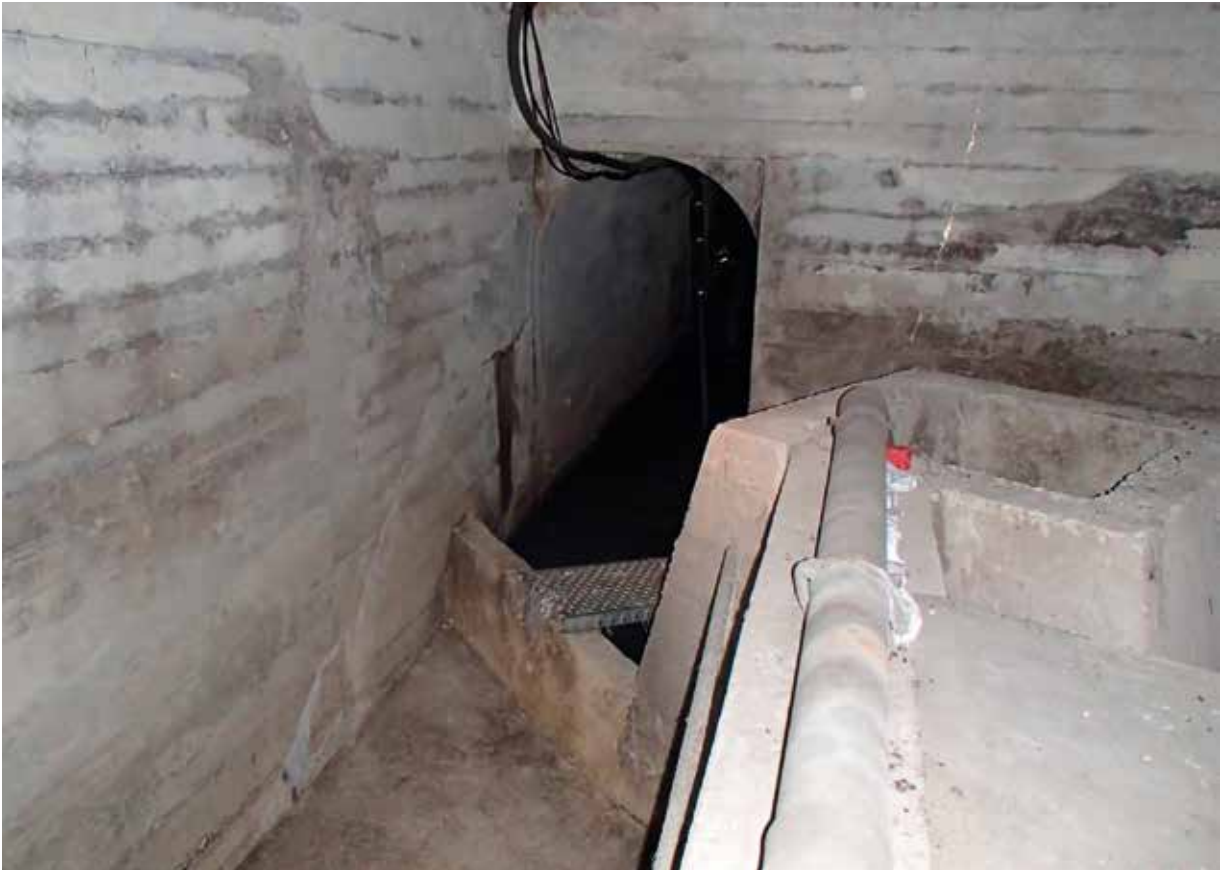
Photo 1 : Géométrie du déversoir d'Ecully (source : Momplot, 2014).
