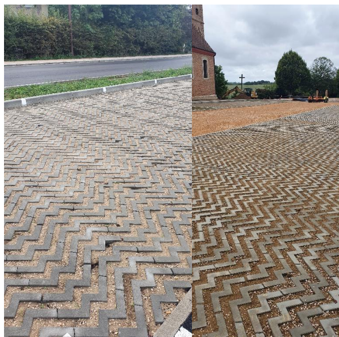
Futurs parkings de la Mairie et Place de l'Eglise, en attente de la pousse de l'herbe
