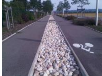
34 km de tranchées
