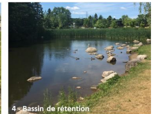
4 - Bassin de rétention
