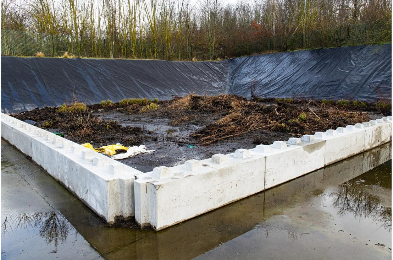
Figure 4 : Déshydratation naturelle mise en place par la Métropole de Lyon dans le bassin de rétention de Minerve (69)
