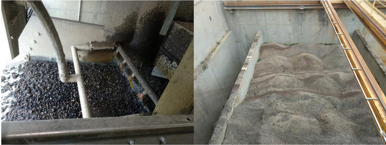
Figure 6 : Procédé de Traitement des Produits de Curage de la STEP de Pierre-Bénite (69), avec à gauche la table densimétrique et à droite le stockage des sables lavés prêts à être récupérés pour valorisation
