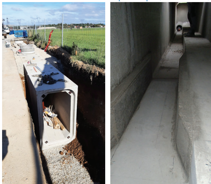
Gauche : Pose de la canalisation rectangulaire | Droite : Le venturi avant la mise en eau.
