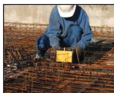
Boîte plomberie (pieuvre) à intégrer au coulage du plancher
