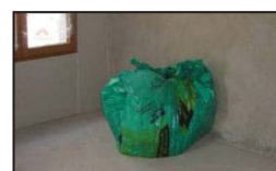
Stockage des chutes pour évacuation
