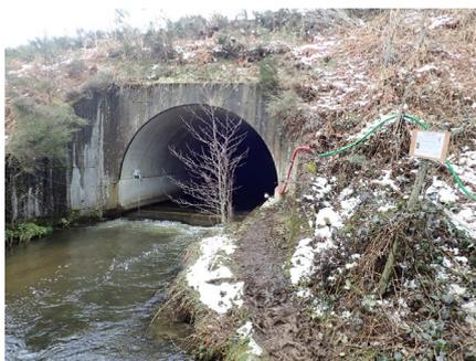
figure 1. OH instrumenté pour évaluer l'efficacité du dispositif de franchissement piscicole (©Cerema)
