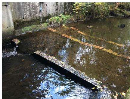
figure 2. Barrette échancrée à l'amont de l'OH et antenne RFID en sortie d'OH (©Cerema)
