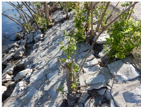
Photo 2 : Déstructuration importante du perré maçonné protégeant la berge
