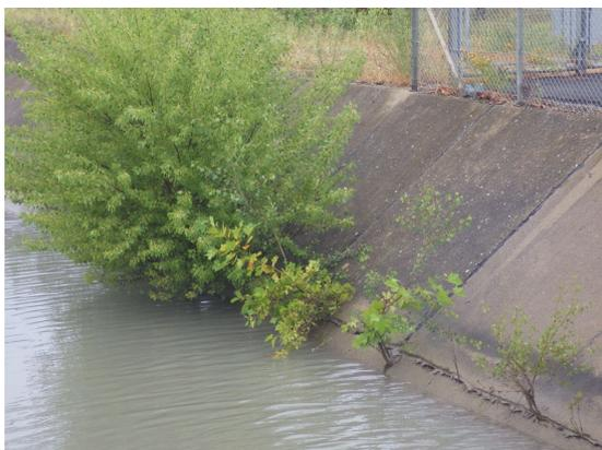
Photo 1 : Dégradation des joints du bajoyers étanche d'un canal
