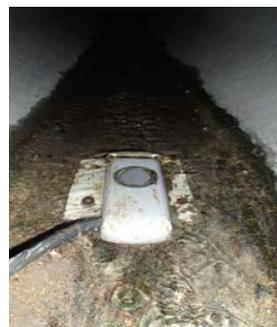
Figure 6. Débitmètre en sortie
