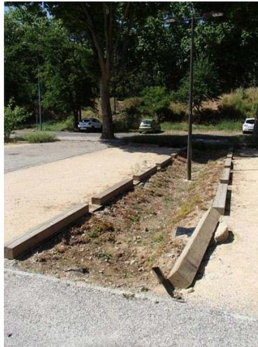
**Figure H. Basculement du madrier servant de butoir pour le parking**
