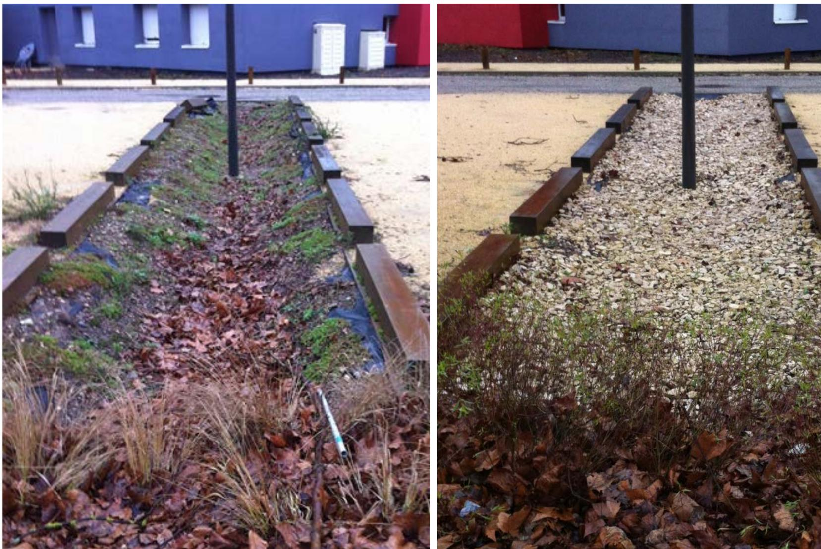
Photo N. Les ouvrages noues (à gauche) et tranchées (à droite) pendant le même temps sont secs (Pluie du 07/02/2016)
