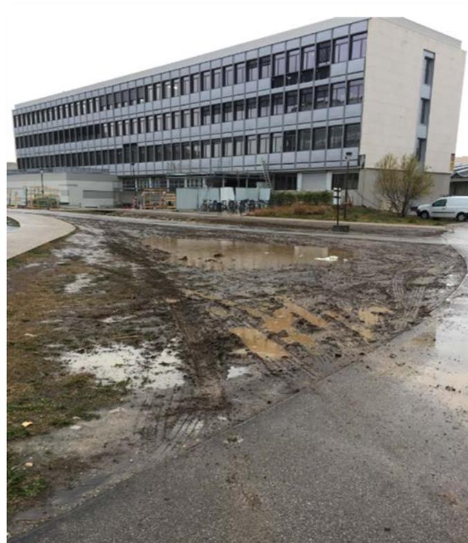
Photo R. Les travaux du campus montrent la difficulté des équipes travaux à considérer les noues enherbées sans indication visuelle particulière comme des ouvrages. Quand la noue est formée de galets en fond, les équipes travaux contournent la noue (Photo de gauche) quand la noue est juste enherbée les camions traversent sans la noue et l'endommagent.
