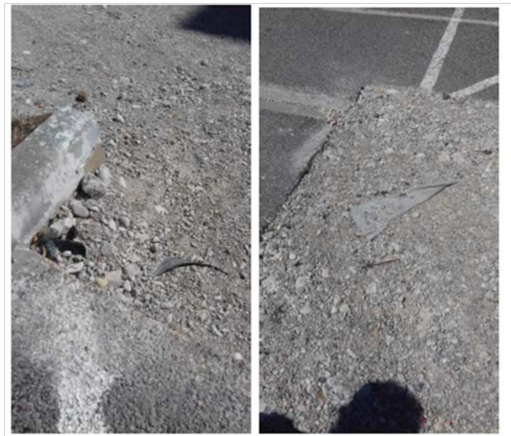
**Photo S. Pendant les travaux : passage des engins dans les noues enherbés mais aussi endommagement (08/11/2018) de la chaussée réservoir pour pratiquer une voie d'accès provisoire malgré les avertissements des chercheurs.**
