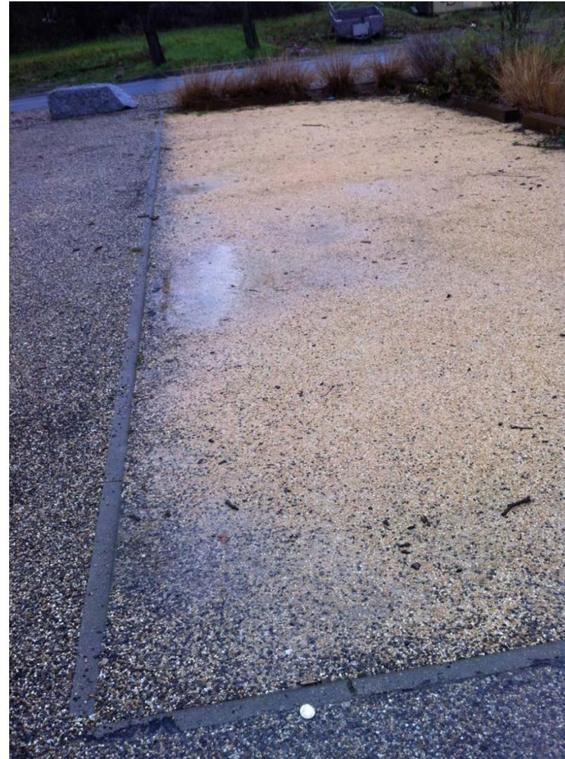
**Photo M. Globalement les surfaces imperméables présentent du stockage dans les dépressions plus important que sur les surfaces en gore. Les surfaces en gore s'imperméabilisent petit à petit (photo de gauche) sous les effets des voitures (Pluie du 07/02/2016)**
