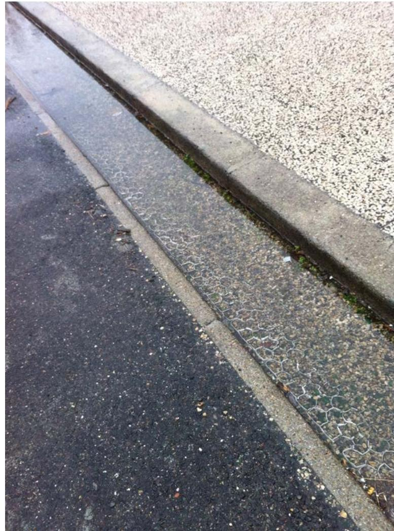
**Photo L. Le Nidagravel® se colmate et n'infiltré pas l'eau Rappelons qu'il a été placé car le bureau d'étude avait peur du colmatage des noues selon M. Lauze. La surface est faible pour l'infiltration et les roues tassent la surface donc sans surprise cela ne fonctionne pas très bien (Pluie du 07/02/2016)**
