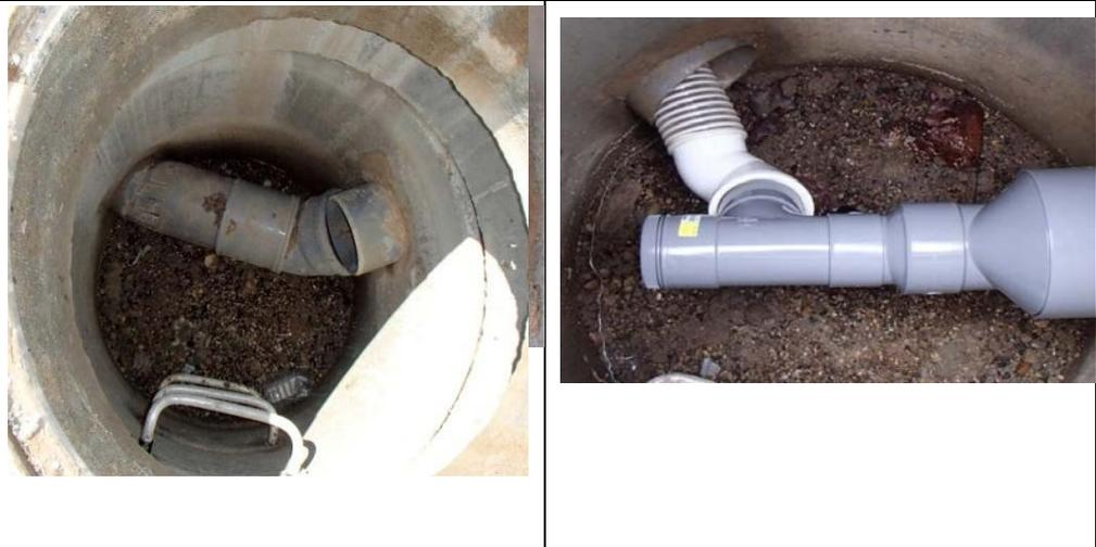
**Figure G. Connexion refaite dans le regard**
