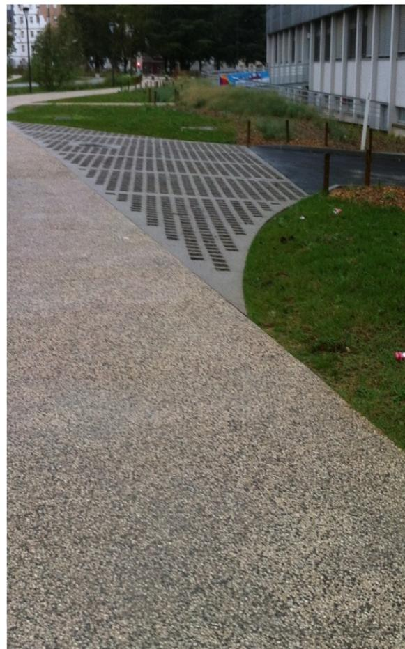
Photo K. A gauche des dalles gazon qui sont colmatées à droite le revêtement perméable est plus efficace bien que moins facilement praticable par les piétons (pluie 07/02/2016)
