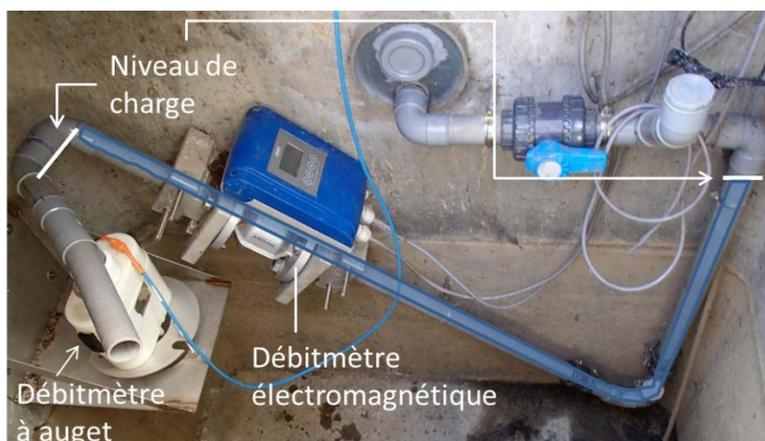
**Figure 7. Dispositif complet de mesure débitmétrique avec complément électromagnétique Krohne (Optiflux IFC 2100C)**
